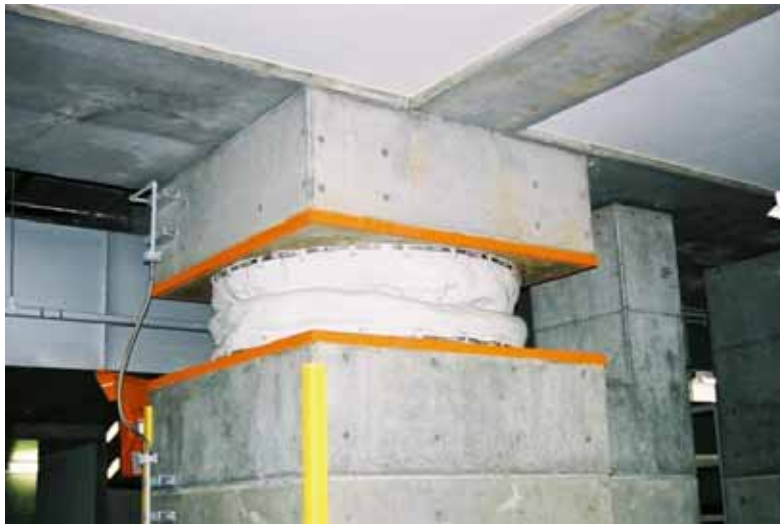
写真6.2 天然ゴム系積層ゴム支承の設置状況
