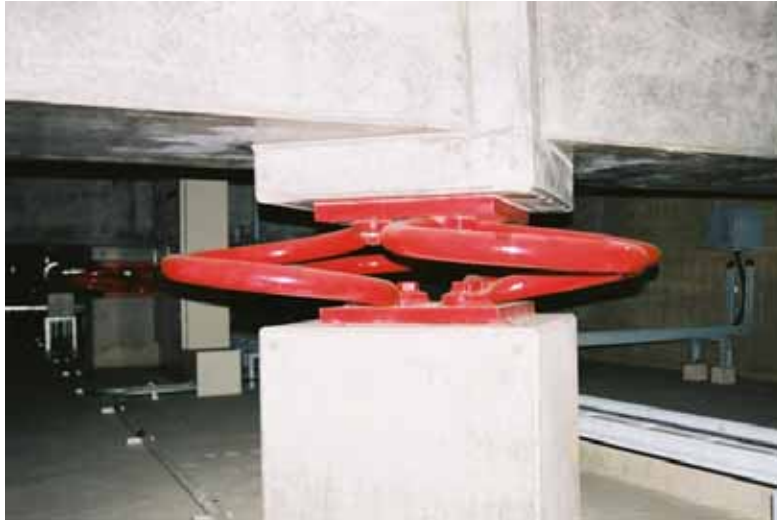
写真6.4 鋼棒ダンパーの設置状況
