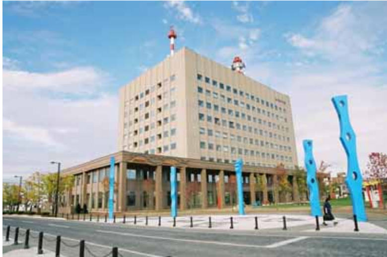
写真6.1 釧路合同庁舎の外観
