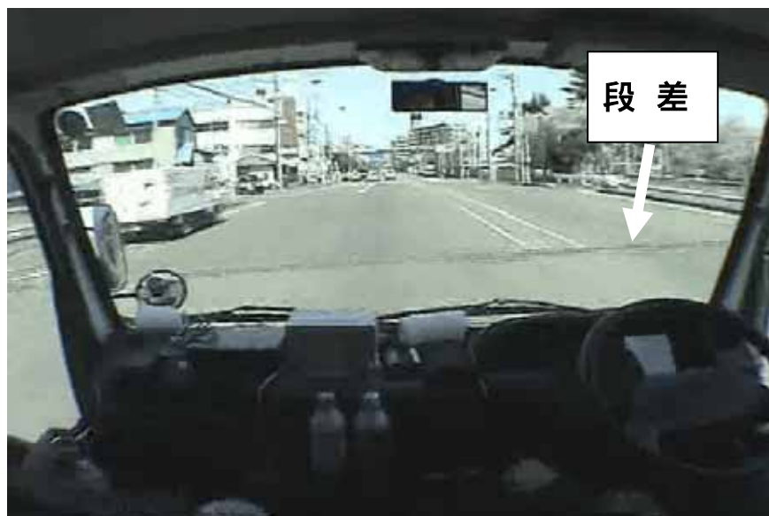
図 3.20 運転席から見た橋梁段差部分の状況
