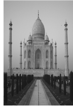
スケーリング
